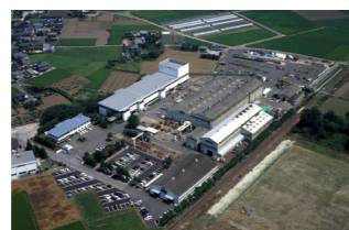
栃木工場(栃木県)
