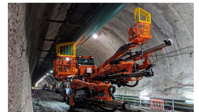
各ブームを自動制御しスピーディーで高精度なせん孔作業を実現
