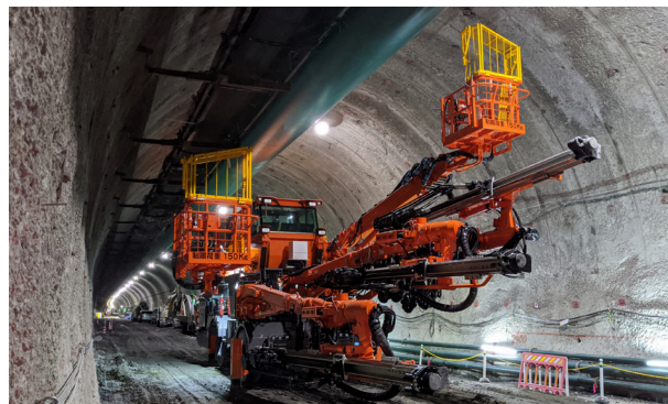
各ブームを自動制御しスピーディーで高精度なせん孔作業を実現
