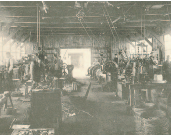
足尾電気機械修繕工場
