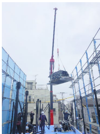
住宅密集地でのクレーン作業
