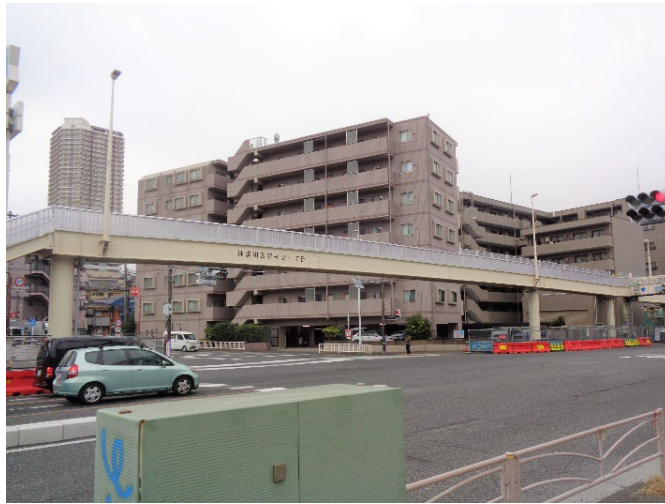
完成した国道 1 号新子安歩道橋
