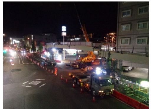
施工中の様子
