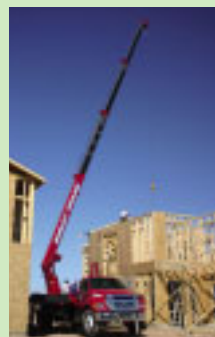
〈大型ユニッククレーン〉
