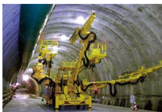
道路や鉄道の山岳トンネル工事で使用され、国内では圧倒的な実績があります。
