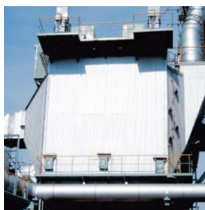
排ガス処理・環境集じん等で使用される電気集じん器
