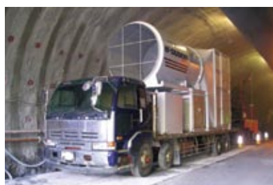
トンネル工事等で活躍する電気集じん器
