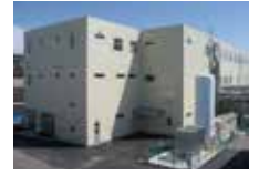
ナイトライド事業室の開発棟を小山工場内に建設
