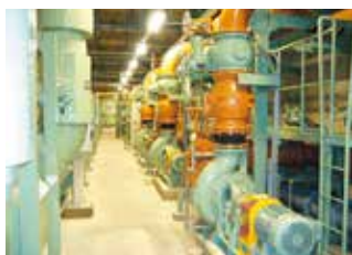
下水処理場で使用される汚泥ポンプ
