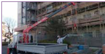
ユニッククレーン
