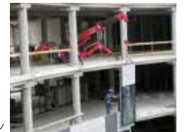
機能性・操作性に優れたミニ・クローラクレーン
