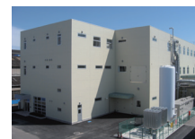
ナイトライド事業室の開発棟を小山工場内に建設
