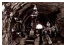
高崎工場ではさく岩機が量産され、当社はさく岩機のトップメーカーとしての地位を固めます
