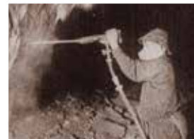
国産第一号のさく岩機は足尾銅山で開発されました
