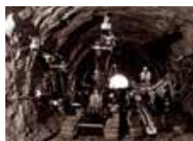
高崎工場ではさく岩機が量産され、当社はさく岩機のトップメーカーとしての地位を固めます
