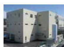
ナイトライド事業室の開発棟を小山工場内に建設
