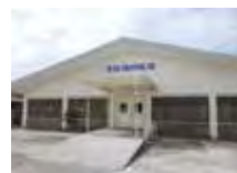
フィリピン・ブラカン州に設立された電子部門の関係会社で、コイルを製造しています
