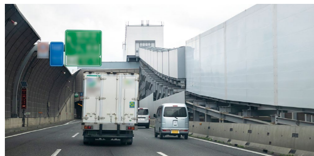
高速道路トンネル工事 長距離・大容量曲送ベルトコンベヤ
