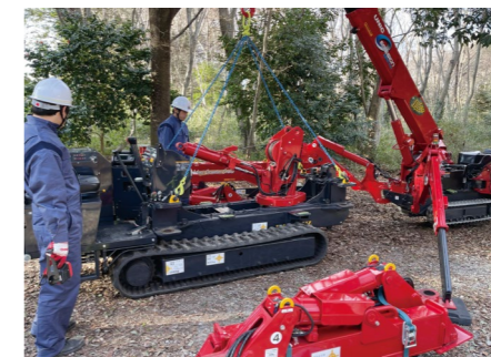
分解式クレーン 山岳地での組み立て作業
