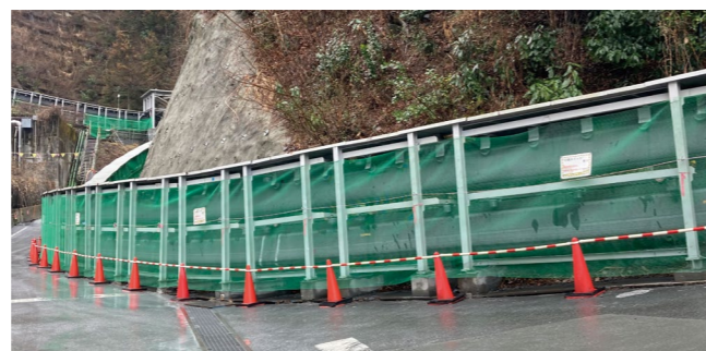
山岳トンネル工事 密閉式吊下げ型コンベヤ(SICON®)
