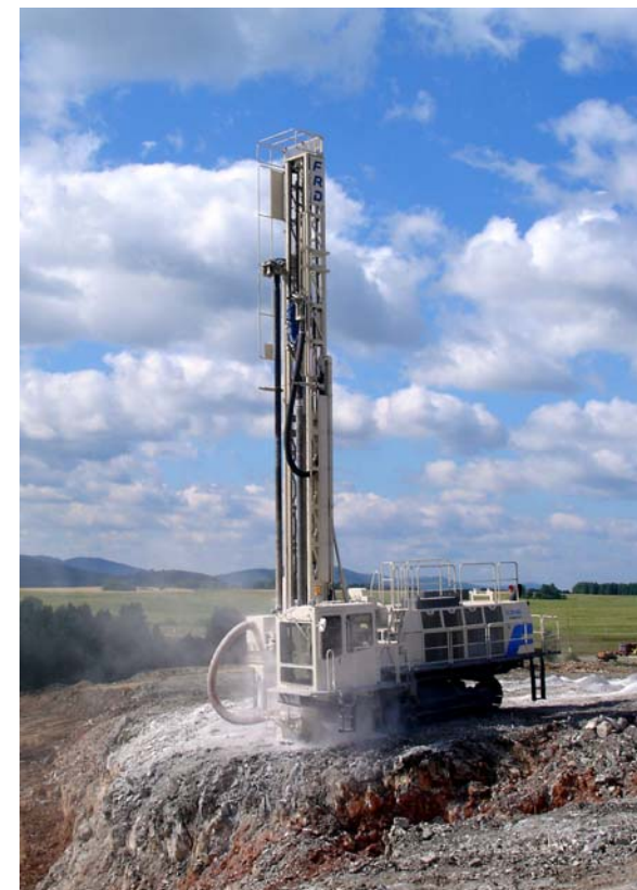
ダウンザホールドリル
