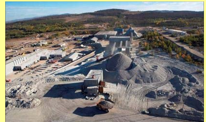
粗鉱から最終製品の精鉱を製造するプラント
