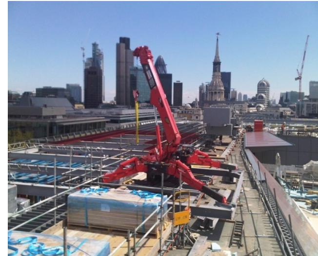
建設現場屋上で資材運搬
