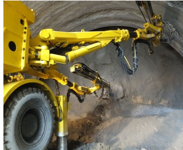
トンネルドリルジャンボ： 岩盤発破に必要な火薬装填用の穴を開ける
