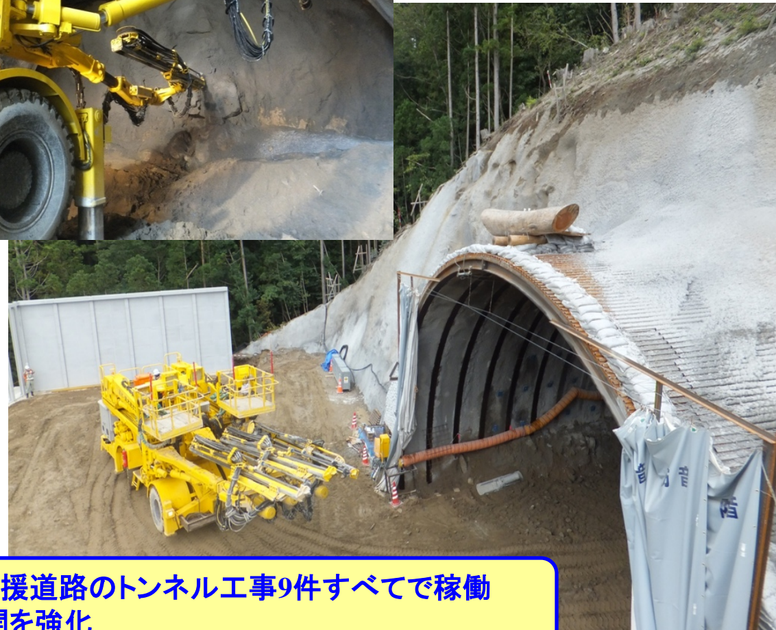
トンネルドリルジャンボ： 岩盤発破に必要な火薬装填用の穴を開ける
