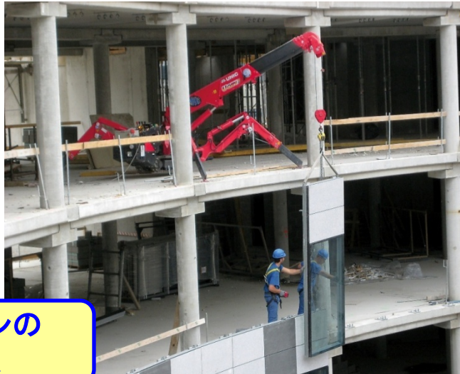
建設現場屋内でラジコン操作による外壁施工
