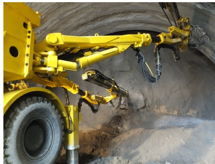
トンネルドリルジャンボ： 岩盤を発破に必要な火薬装填用の 穴を開ける
