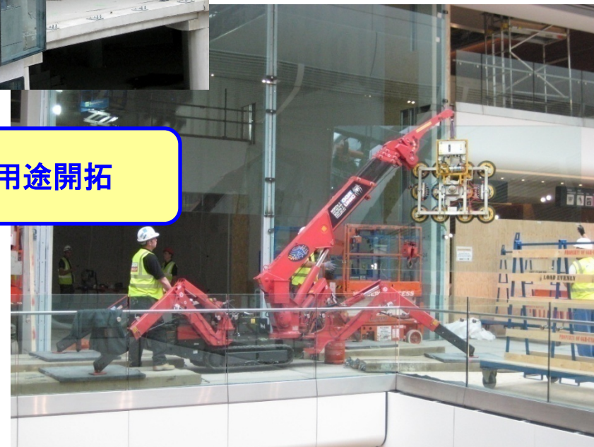
ショッピングモール内で ガラス施工
