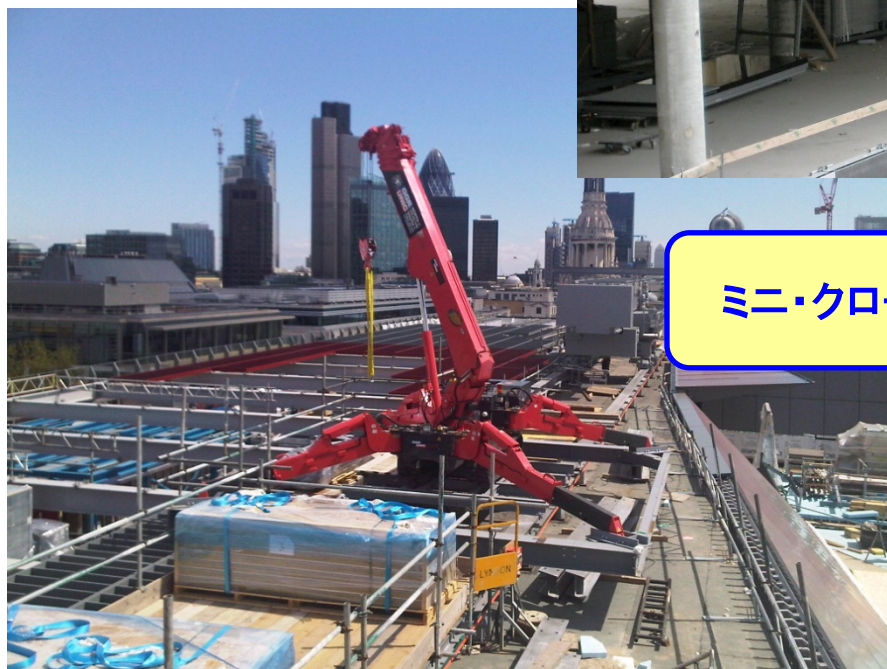
建設現場屋上で資材運搬
