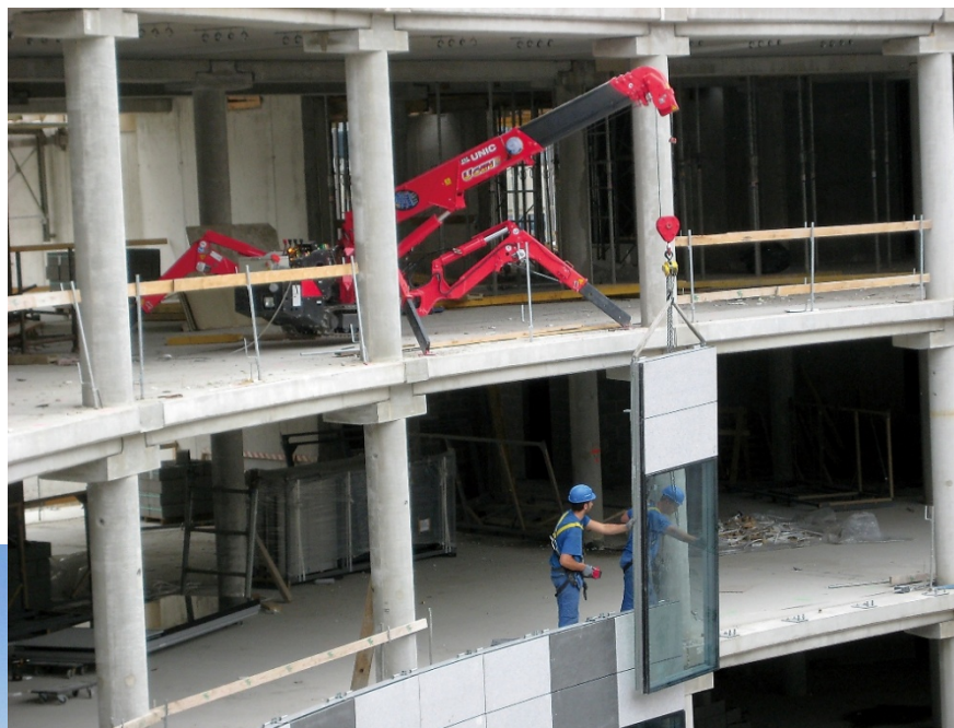
建設現場屋内で ラジコン操作による外壁施工
