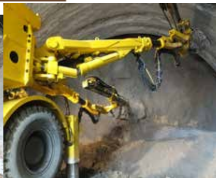
トンネルドリルジャンボ： 岩盤発破に必要な火薬装填用の 穴を開けるロックドリル
