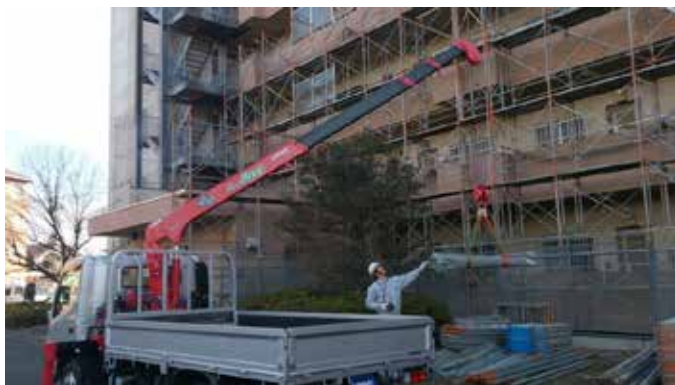
ユニッククレーン: 建築資材などの運搬と、積み降ろし作業が 一台できるトラック搭載型クレーン
