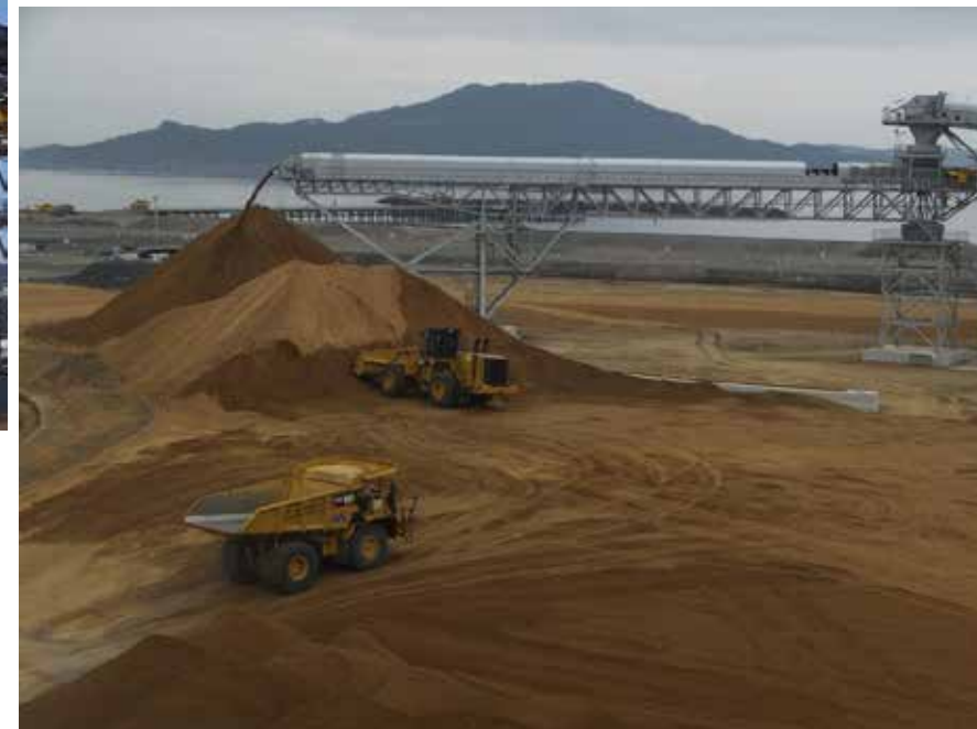
旋回コンベア:先端が半円状に動くため、 大量の土砂を仮置きできる
