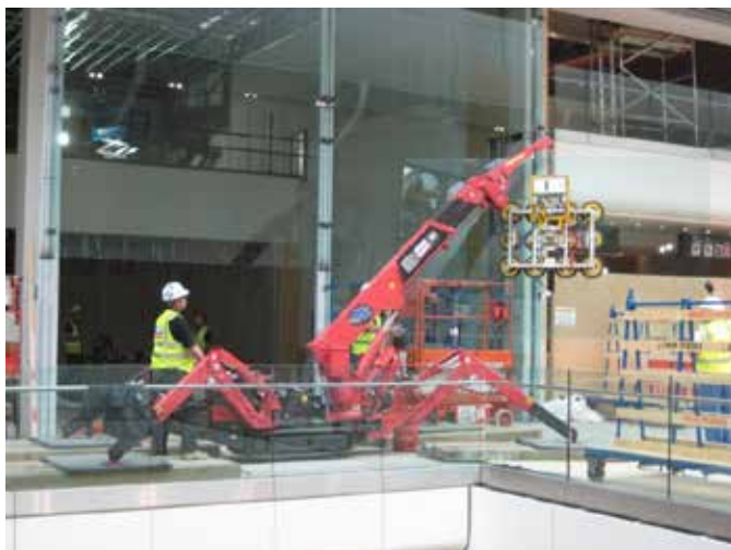
建設現場屋内でガラス外壁施工
