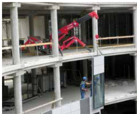
ミニ・クローラクレーン: トラックの入り込めない場所で作業可能な 自走式クレーン
