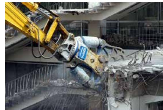
油圧圧碎機: コンクリートの解体に使用する油圧ショベル のアタッチメント製品
