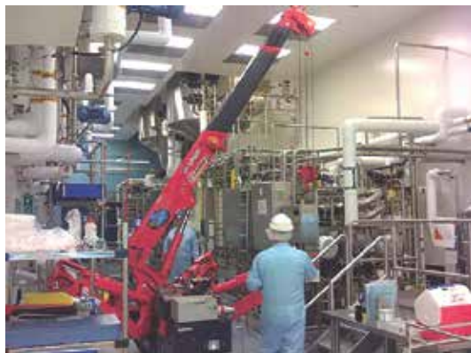
屋内の狭いスペースで作業
