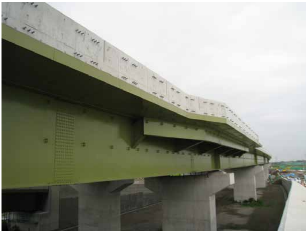
圏央道の橋梁工事
