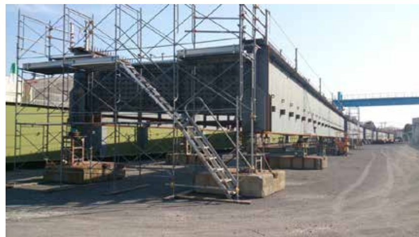
小山工場での仮組の様子
