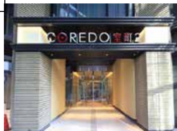
B1-6階 商業施設 (COREDO室町2)
