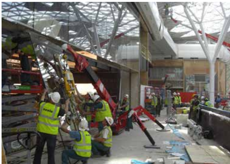
コンパクトで自走可能なミニ・クローラークレーンは、建設現場や屋内の狭いスペースで作業可能なため、欧米を中心に用途開拓が進む
