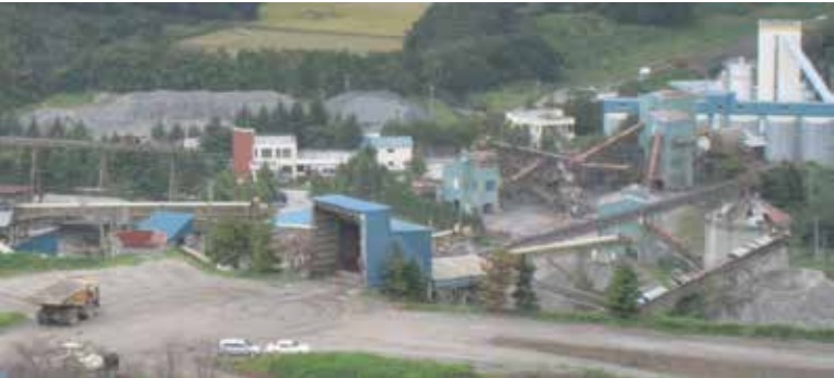
ダンプトラックで運ばれた岩石を破碎プラントに投入
