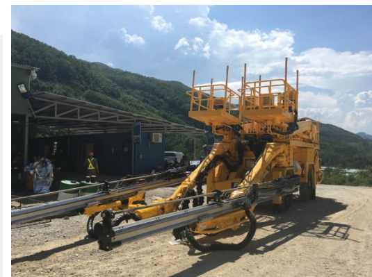
ベトナムで稼働する2ブーム2ケーシージャンボ
