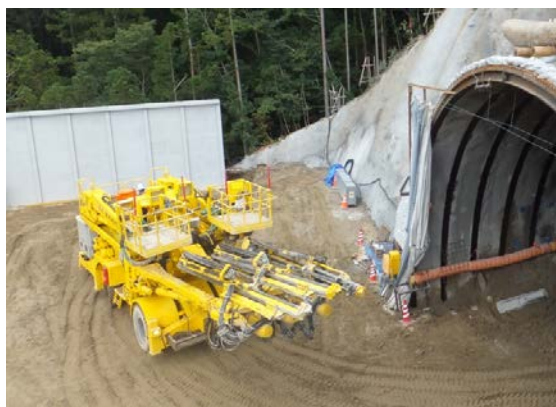
トンネルドリルジャンボ： 岩盤発破に必要な火薬装填用の 穴を開けるロックドリル
