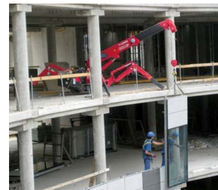
ミニ・クローラークレーン： トラックの入り込めない場所で 作業可能な自走式クレーン
