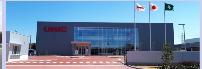
ショールームを備えた事務研修棟
