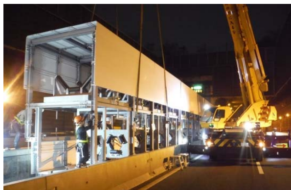
東京外環道向けベルトコンベヤ設置
