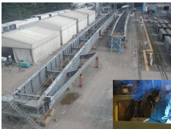
横浜環状北西線向け橋梁 (仮組み)
