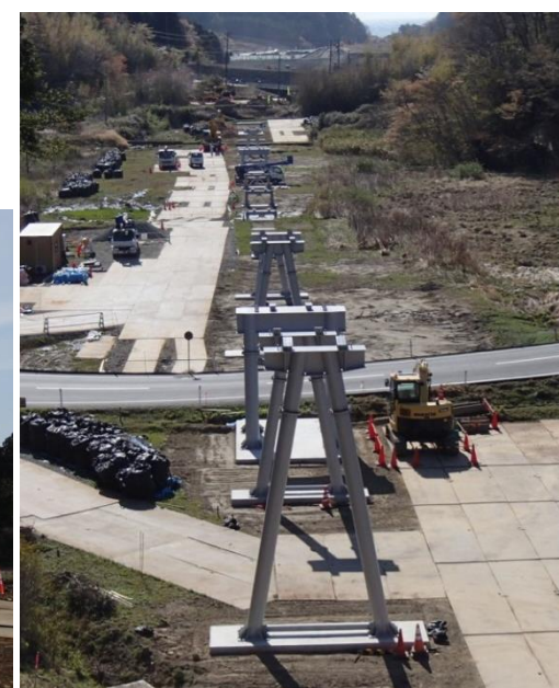
設置工事が進む分別施設から中継ヤードまで運搬するためのベルトコンベヤ
