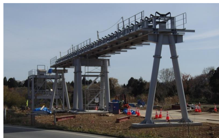
設置工事が進む分別施設から中継ヤードまで運搬するためのベルトコンベヤ
