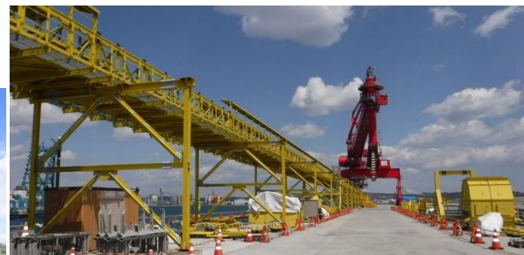
ベルトコンベヤの設置工事状況
