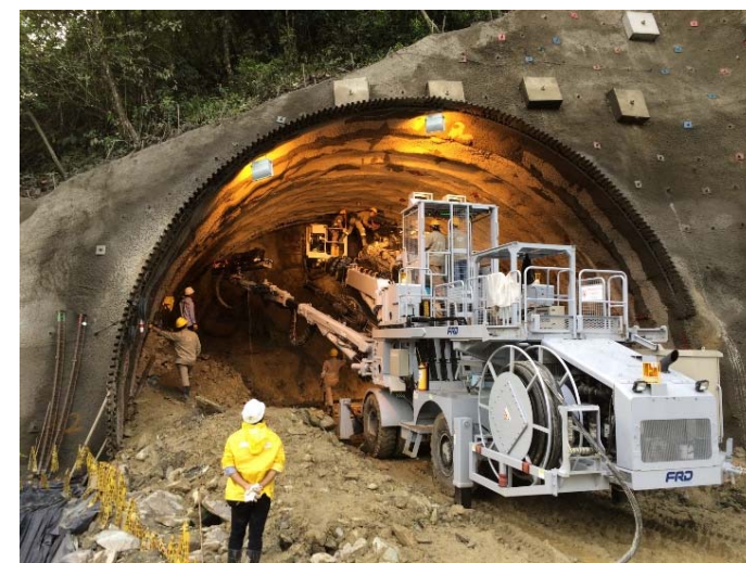
海外のトンネル掘削現場で稼働するドリルジャンボ
