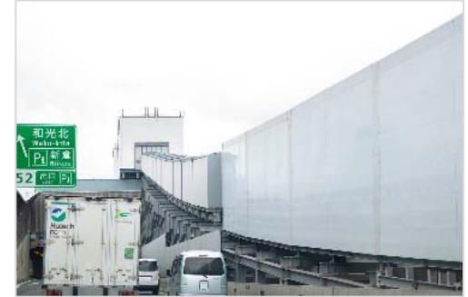
東京外かく環状道路工事向けベルトコンベヤ
