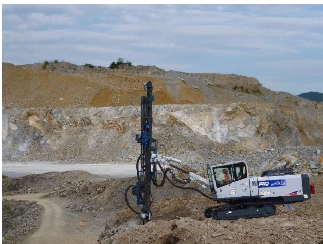
海外の碎石現場で作業する油圧クローラドリル
