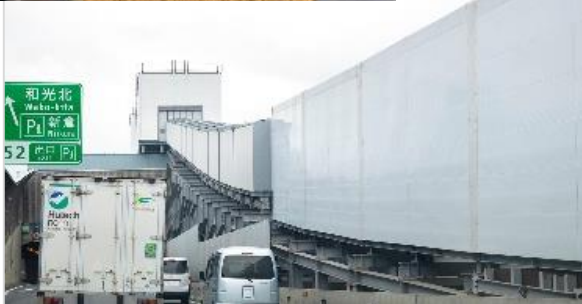
東京外環自動車道工事向けベルトコンベヤ
