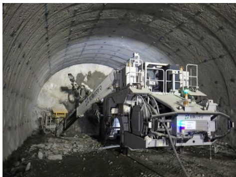
遠隔技術を活用したトンネルドリルジャンボ(株式会社安藤・間、マック株式会社と共同開発)
