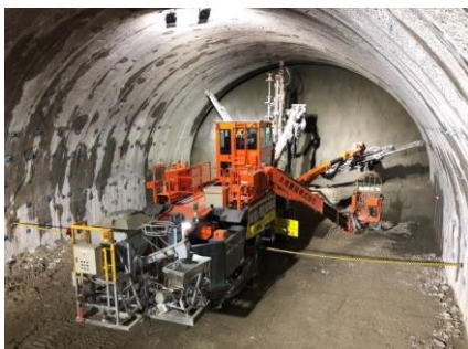
6m継ぎボルト打設装置を搭載したロックボルト専用機「BOLTINGER」(大成建設株式会社と共同開発)
