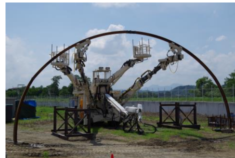
鋼製支保工建込みロボット(前田建設工業株式会社、マック株式会社と共同開発)
