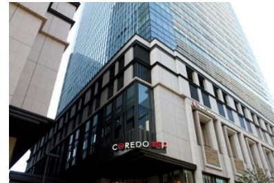
室町古河三井ビルディング (COREDO 室町2) 中央区日本橋室町
