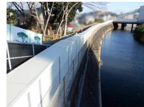
河川治水関連事例（調節池造成工事） 密閉式吊下げ型コンベヤ（SICON®）
