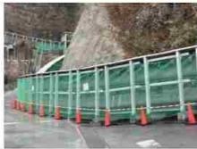
山岳トンネル工事
