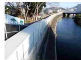
調節池造成工事 (住宅街での適用事例)
