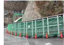
山岳トンネル工事
