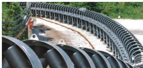
パイプコンベヤ
