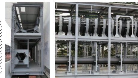
設置するベルトコンベヤの仮設
