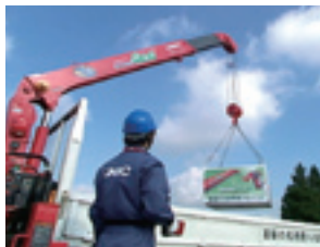
ユニッククレーン
