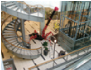
ミニ・クローラークレーン
