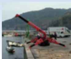
ミニ・クローラークレーンによる復興作業
