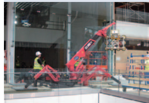
▼ 建設現場屋内で外壁施工（ラジコン操作）
