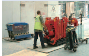
▼ ショッピングモール内でガラス施工
