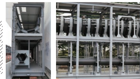
設置するベルトコンベヤの仮設
