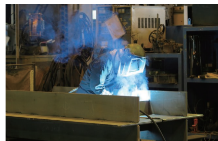
小山工場 溶接工程
