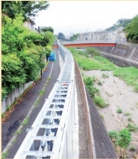
ベルトコンベヤ設置工事の様子
