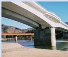
橋梁・鋼構造物
