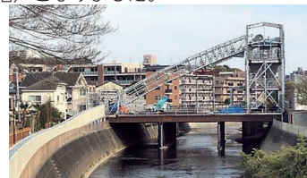
境川金森調整池造成工事現場
