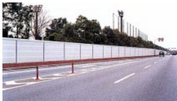
防音壁に酸化チタンをコーティングした例
