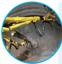
1 トンネルドリルジャンボでトンネルの形に穴を掘ります。
