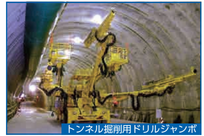
トンネル掘削用ドリルジャンボ
