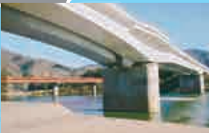
橋梁・鋼構造物 歩道橋や自動車道などを建設しています。
