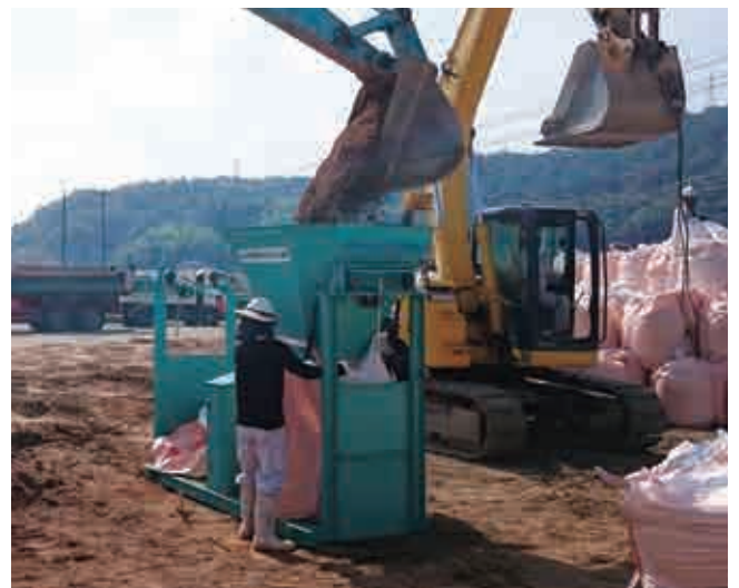
西日本豪雨災害復旧工事（砂川地区）
