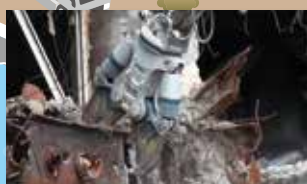
■圧砕機 ビル解体現場などでコンクリートの破砕や鉄骨・鉄筋の切断に使用されています。
