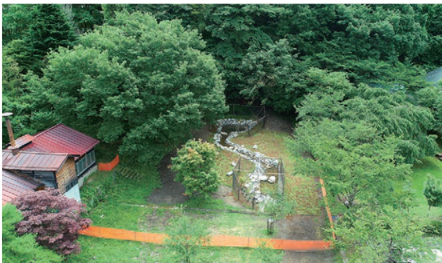
造成中のホタル池(日光市足尾町社有地内)
