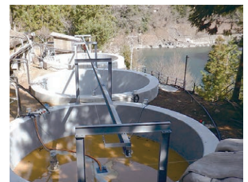
新設した貯泥槽(久根鉱山)
