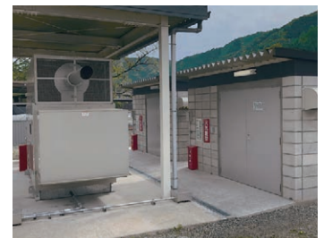
新設した燃料倉庫(足尾鉱山)
