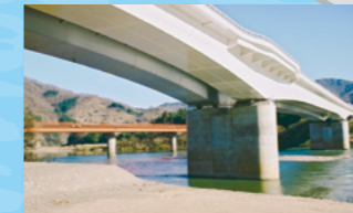
■橋梁・鋼構造物 歩道橋や自動車道などを建設しています。
