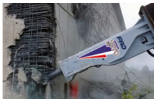
■油圧ブレーカ 岩石の小割りやコンクリートの破砕に使用されています。
